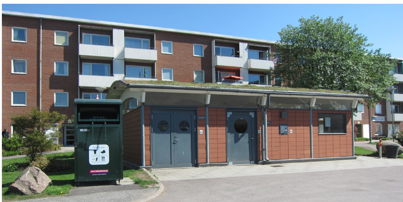
Avfallsutrymmens placering behöver noga övervägas för att skapa en trygg och ändamålsenlig avfallshantering. FOTO: DAVID ALTHOFF PALM, RAMBOLL.
