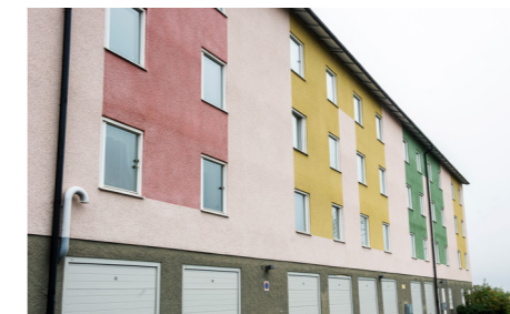
Fasaderna mot Flintlävsvägen.
